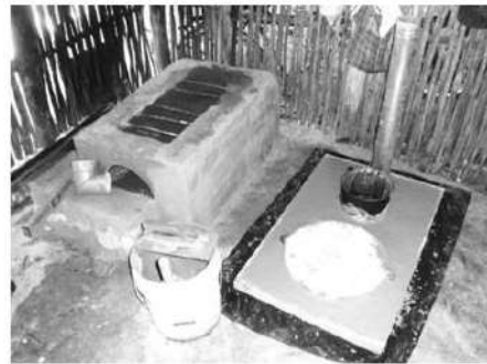
Después del colado de tapa
