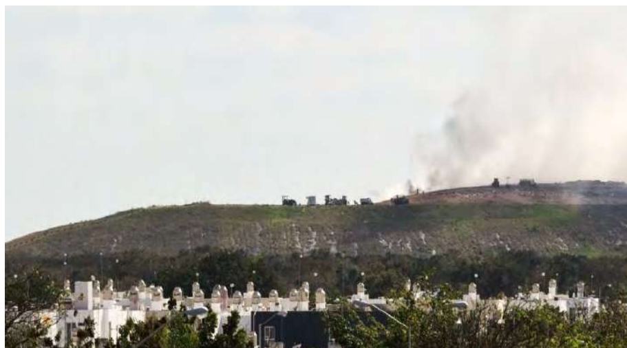
Figura 6. Relleno sanitario de la ciudad de Mérida. Vista desde el Fraccionamiento Sian Ka'an IV de Ciudad Caucel. Silva, 2023.
